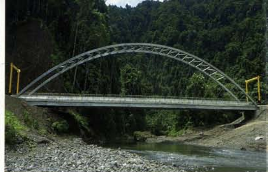
Maepua Bridge, Solomon Islands Type : Steel Network Dimension : Length 72 m, Width : 10 m
